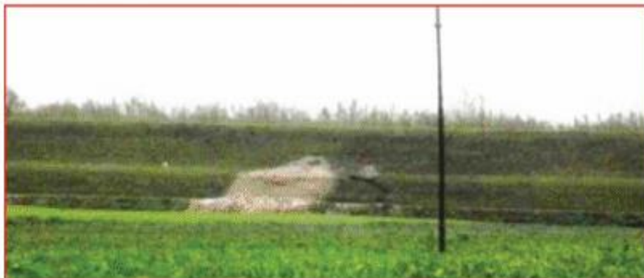
08.15 CET Venuta arginale laterale nell'argine
